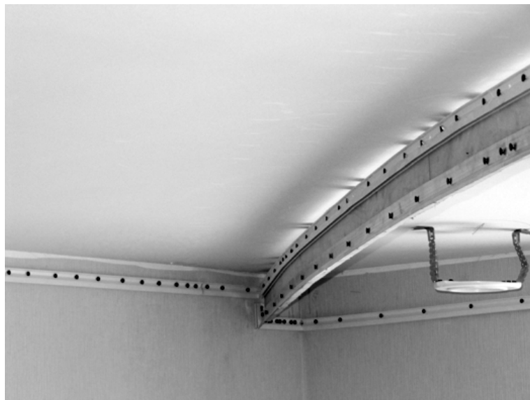
Фото 8 (Конструкция перегиба с демонтированным потолочным багетом)
