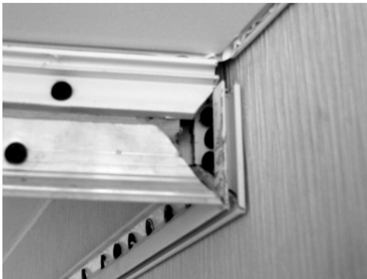
Фото 3. (Конструкция перегиба в сборе с установленным полотном первого уровня.)
