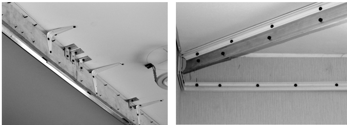
Фото 5 и 6 (Конструкция перегиба и укладка багета для полотна второго уровня)
